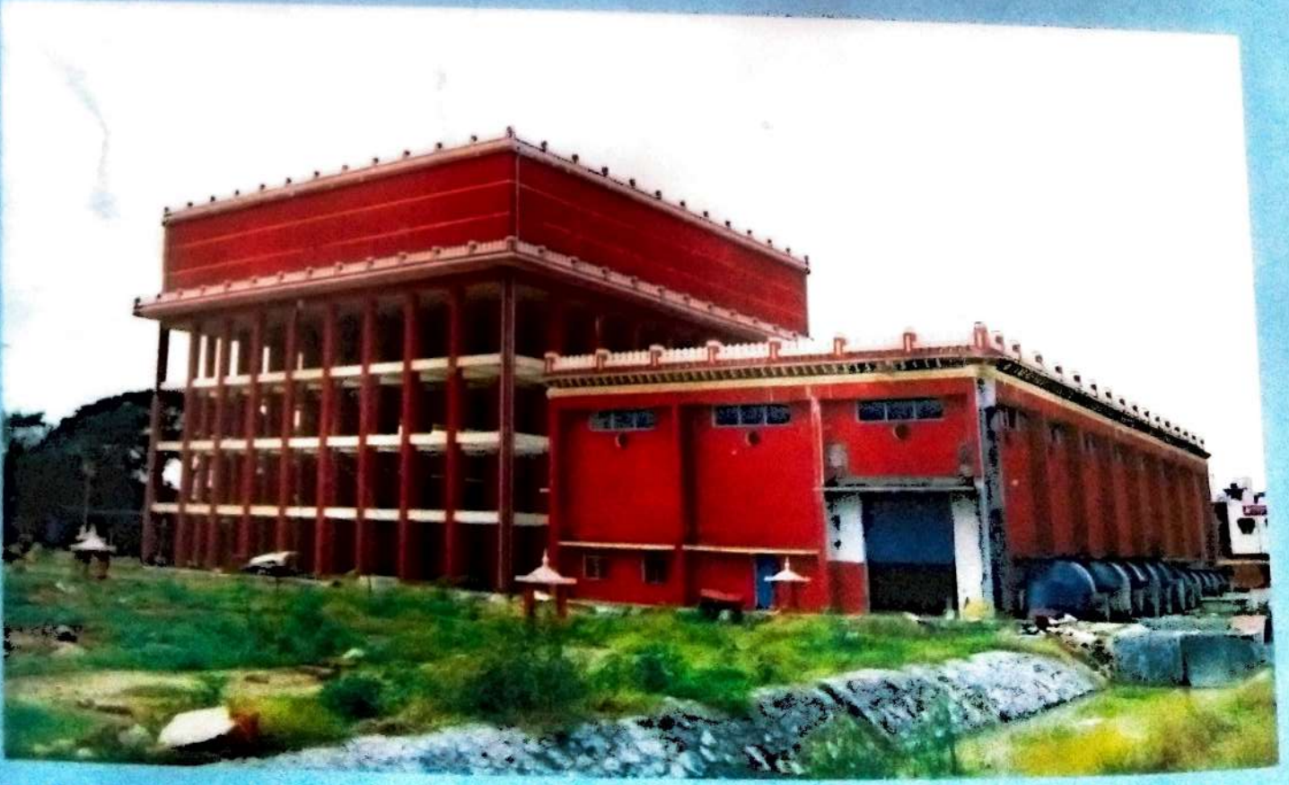
சென்னைக் குடிநீர் வாரியத்தால் புதியதாகக் கட்டப்பட்டுள்ள கீழ்ப்பாக்கம் மேல்நிலை நீர்த்தேக்கத் தொட்டி. கீழ்நிலை நீர்த்தேக்கத் தொட்டி மற்றும் நீரேற்று நிலையம் Newly constructed overhead tank, underground tank and pumphouse at Kilpauk
