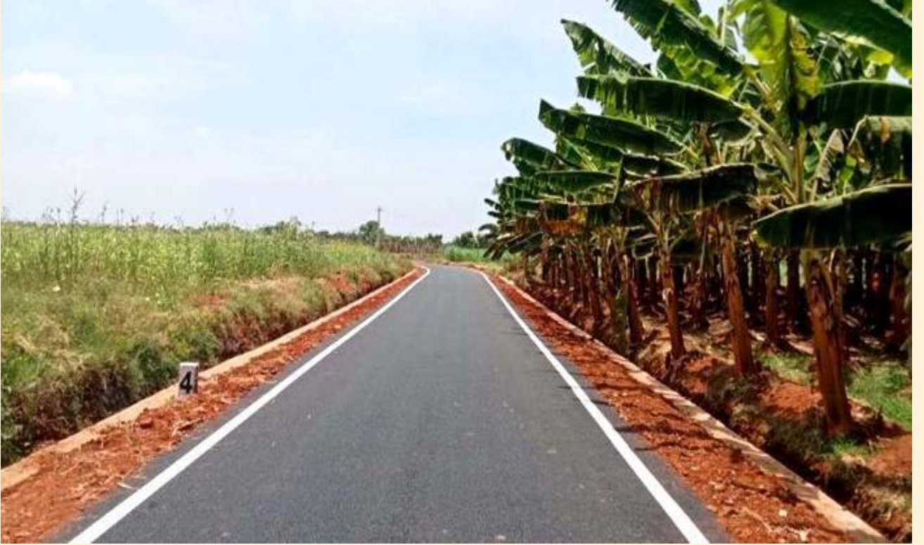
ஈரோடு மாவட்டம் - லக்கம்பட்டி பேரூராட்சி, வள்ளியம்பாளையம் சாலை - வெல்லங்காட்டு பாளையம் தடுப்புச் சுவருடன் கூடிய தார்சாலை அமைத்தல் - மதிப்பீடு 1.22 கோடி.
